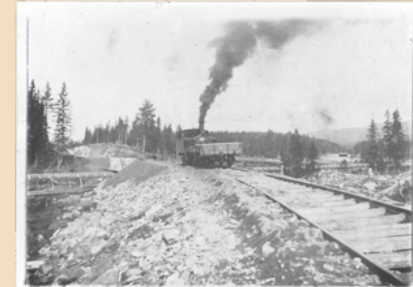
Valdresbanen under bygging (1901-1906). På bildet sees det første lokomotivet på banen. Trerenna som her passerer under jernbanelinja, ble bygget i 1901. Foto utlånt av Per Odneæs.
